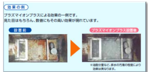
<設置前・設置後>
